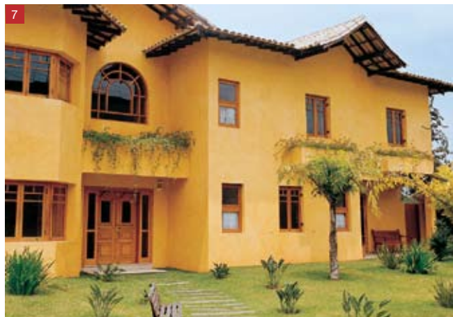
Pintura com cal feita com 1 kg de Pó Xadrez Amarelo em 8 kg de cal.
